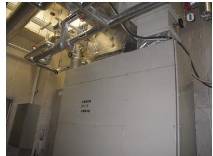
写真4 収蔵室空調を制御する機器
