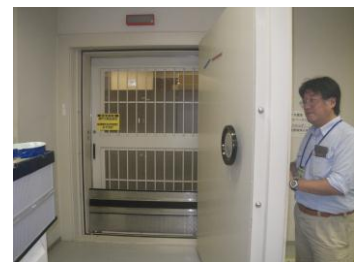
写真2 第1収蔵室耐火扉
