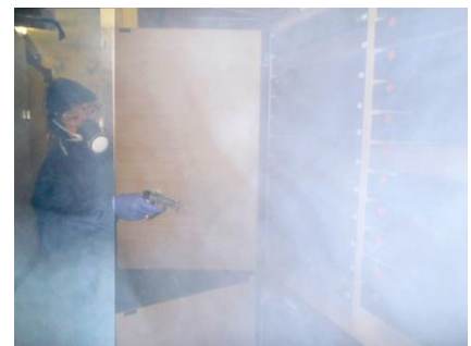
写真5 収蔵室の殺虫薬剤噴霧作業
