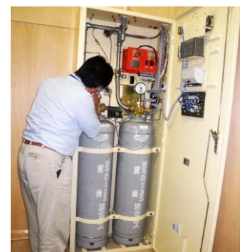
写真3 第4収蔵室自動消火設備
