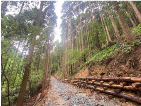
<整備後（安富町関地区）>
