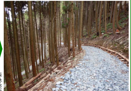
<市有林内に開設した作業道（安富町地内）>
