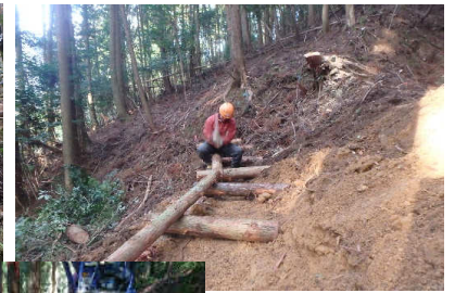
<法尻土留工（作業中）>
