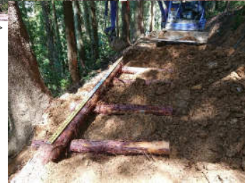
<路面処理工（作業中）>
