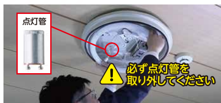
不適切なランプ交換をしている様子
