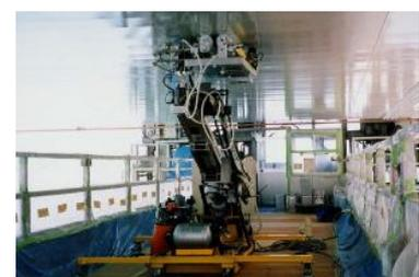
写真4 塗装用ロボット
