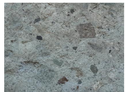
写真2 大手門横石垣 (礫を含んだ凝灰岩)
