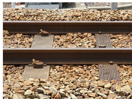
写真2 コンクリート枕木(左)と木製の枕木(右)
