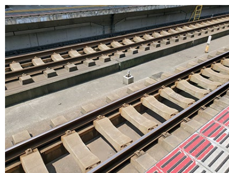
写真3 コンクリート道床 (姫路駅・在来線)
