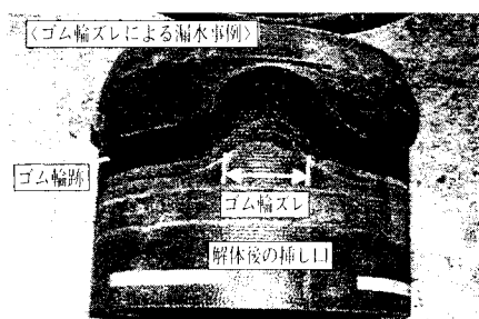
図 11-22 ゴム輪ズレによる漏水事例
