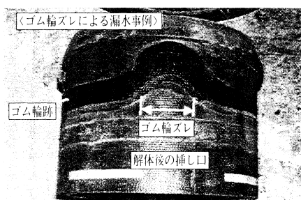
図 11-22 ゴム輪ズレによる漏水事例
