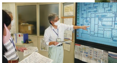
配水コントロール室(保城浄水場)
