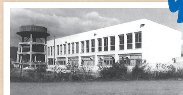
保城水源地に完成した浄水管理センター
