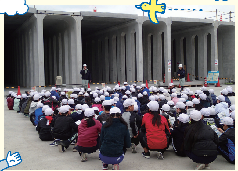
令和元年7月に完成した糸引公園雨水貯留施設
