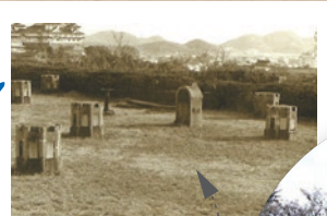
完成時の男山配水池
