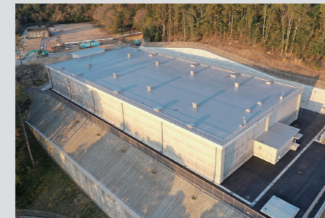
令和2年度に竣工した第2配水池
