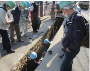
配水管工事を見学
