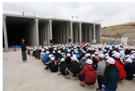
雨水貯留施設工事の見学風景（糸引公園）
