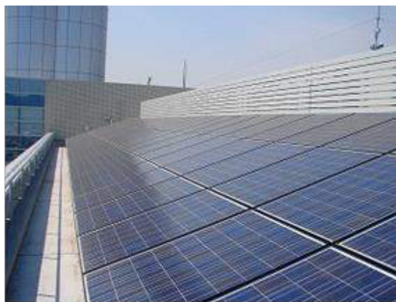
防災センター
