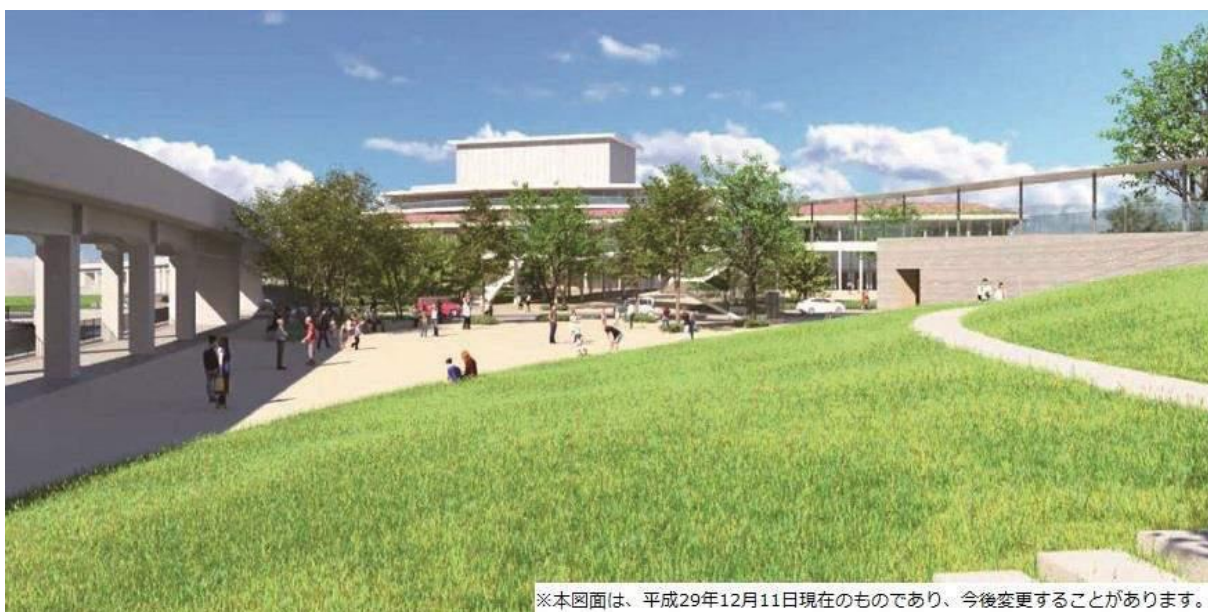
（仮称）姫路市文化コンベンションセンターの外観イメージ
