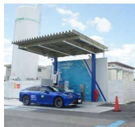
水素ステーション
