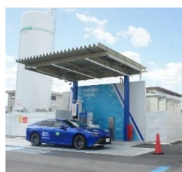
水素ステーション
