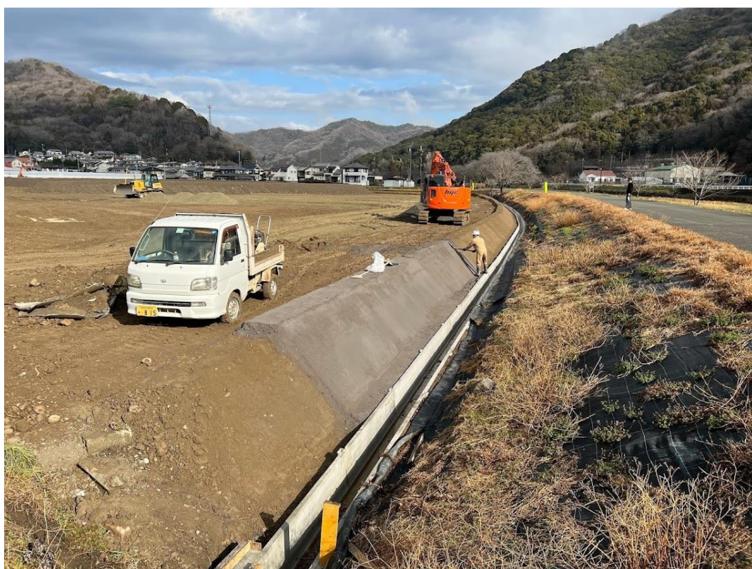
鉄鋼スラグによる畦畔の舗装と通電性向上 電気柵による農地整備が進展
