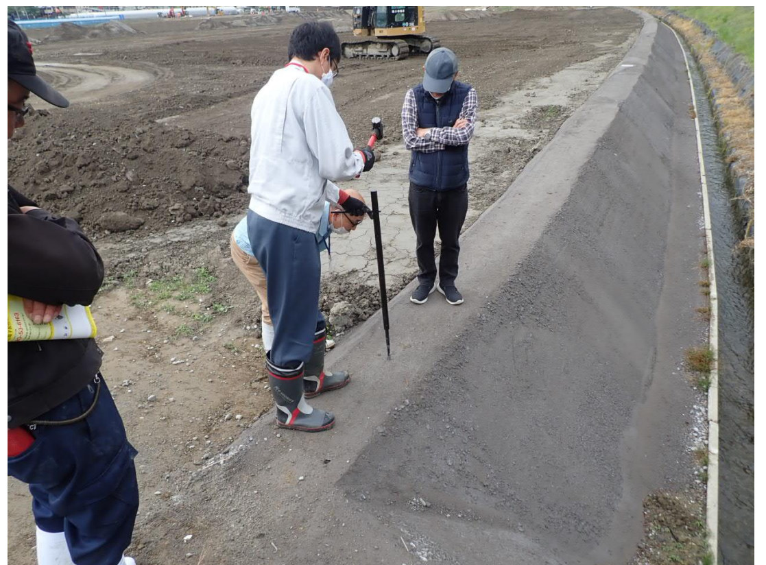
鉄鋼スラグ上面に電気柵を施工
