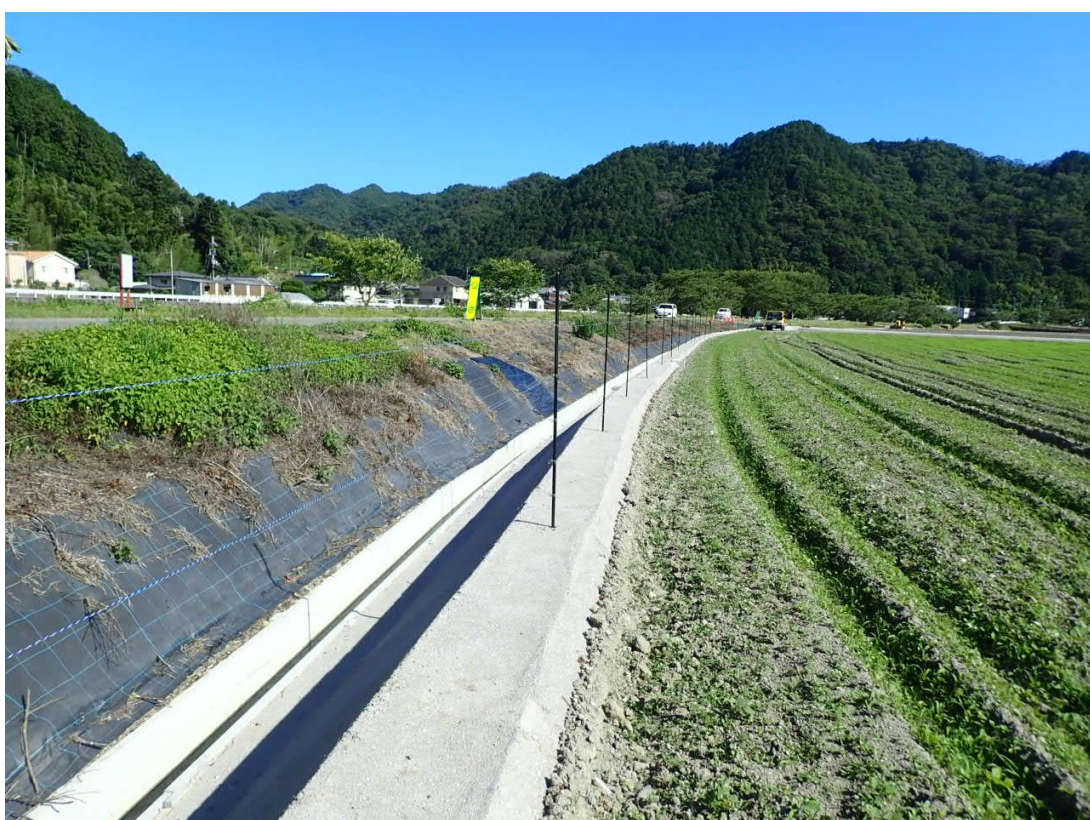
鉄鋼スラグと電気柵の基盤整備が完成
