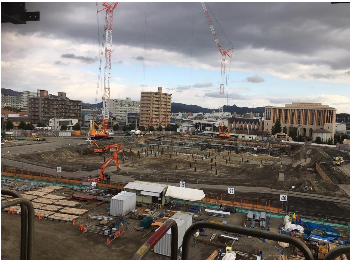
②写真2(文化コンベンションセンター側(西)から)
