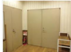
施設内の連絡扉
