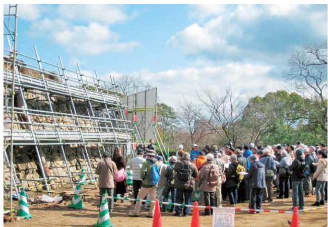
石垣整備に関する現地説明会
