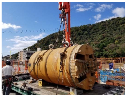
No.7立坑に到達した泥水式推進機。500m以上砂礫地盤と格闘したため、超合金でできたカッタービットもだいぶすり減っていました。
