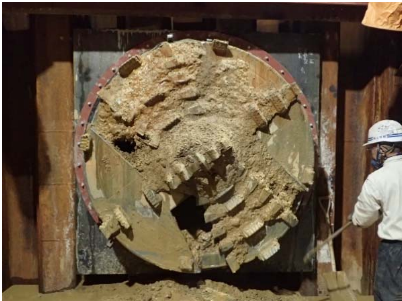
No.7立坑に到達した泥水式推進機。500m以上砂礫地盤と格闘したため、超合金でできたカッタービットもだいぶすり減っていました。
