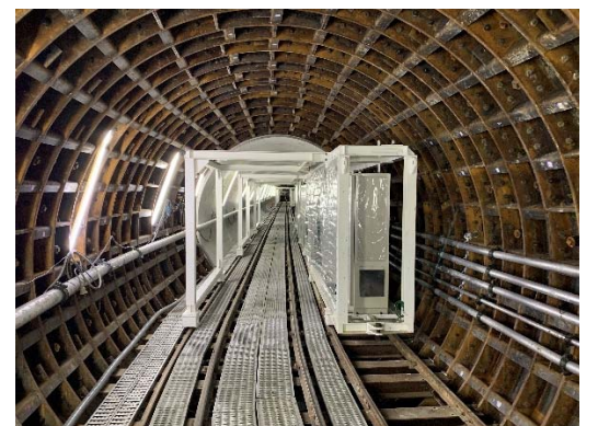
後続台車が入るとトンネル内部はこんな様子です
