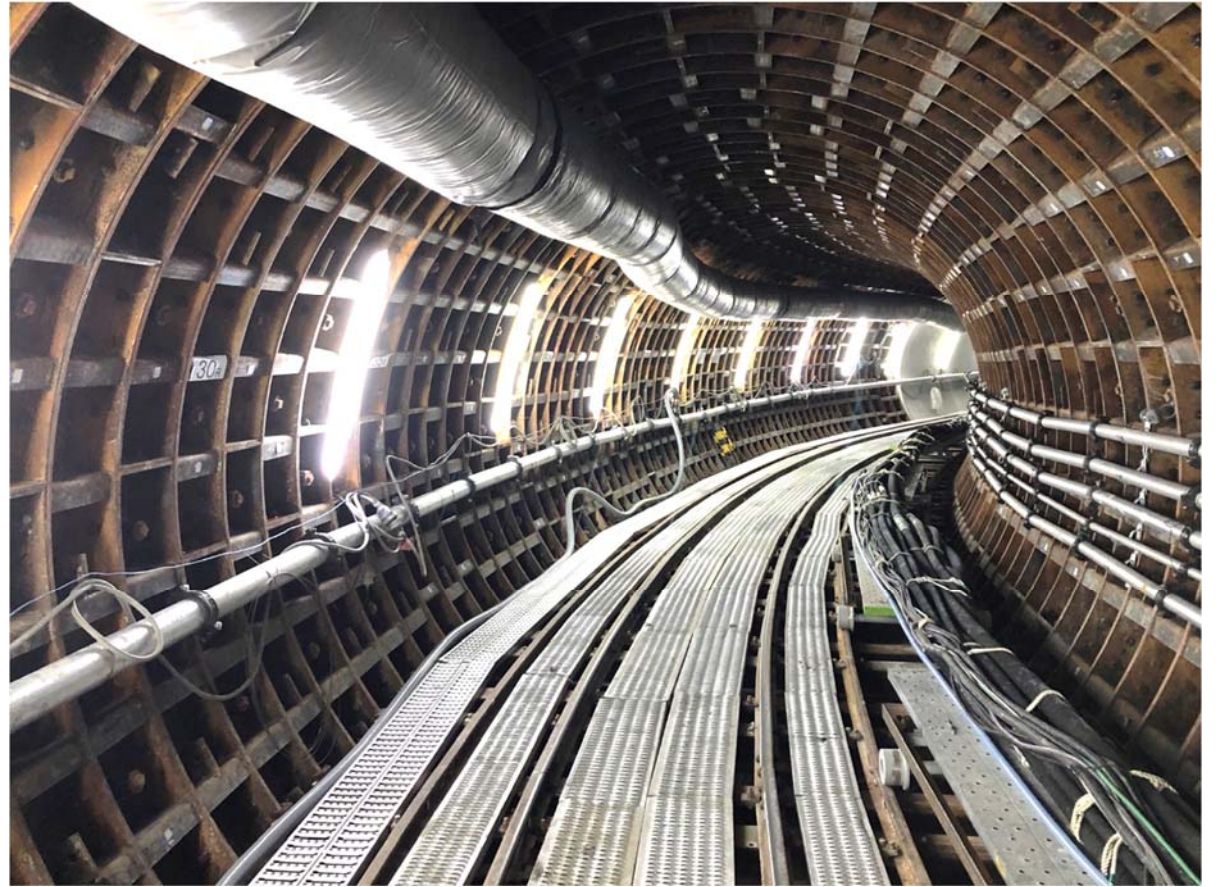
発進直後の急曲線(半径=30m) 幅30cmの鋼製セグメント(ブロック)を組立て、少しづつ曲がっていきます 小坂公園から発進して県道と久今宿線の下を掘るため、このような急カーブが必要になります
