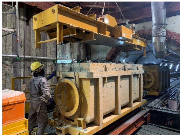
ズリ鋼車は1台で9t 1.2mで4台分土砂を運搬
