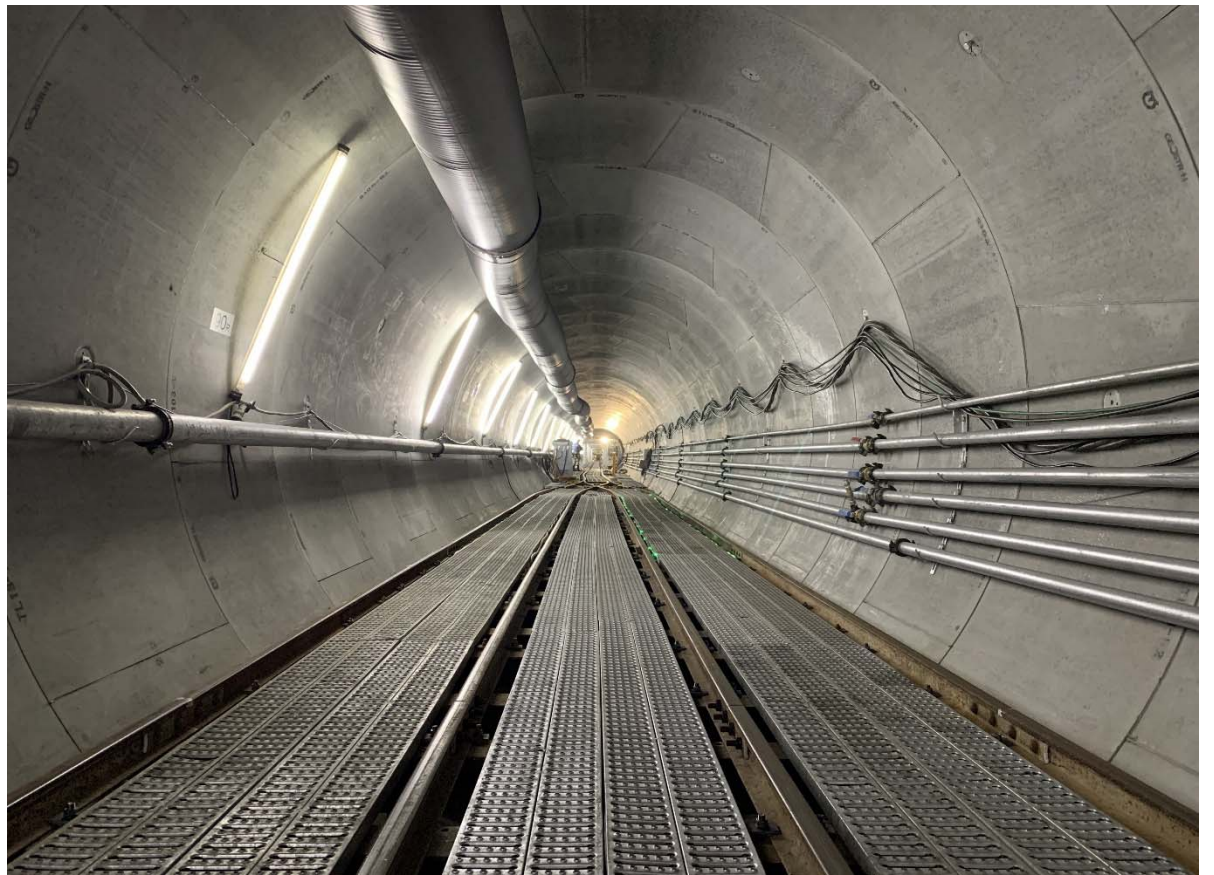
100m 付近の複線軌条区間 土砂、セグメントを運搬するバッテリー式の機関車がすれ違えるよう、レールを複線にしています
