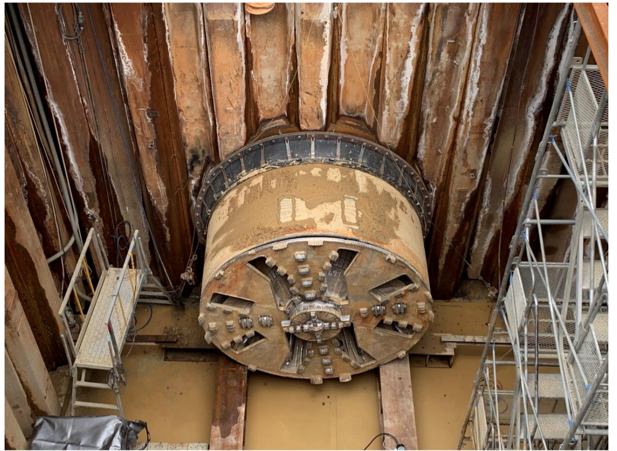
No.5立坑に顔を出したφ2400泥水式推進機 姫路の強固な砂礫地盤と266mにわたって闘ってきました
