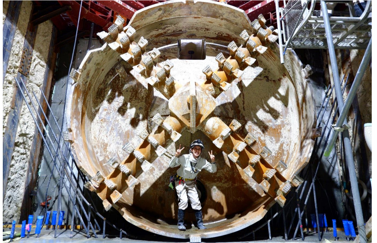
到達立坑に出てきたシールドマシンの前でピースサイン 工事中の苦勞が報われる瞬間です
