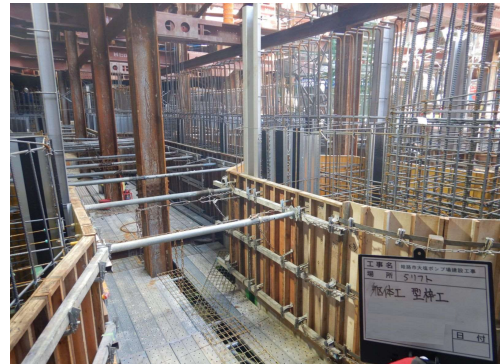
【型枠組立状況】
