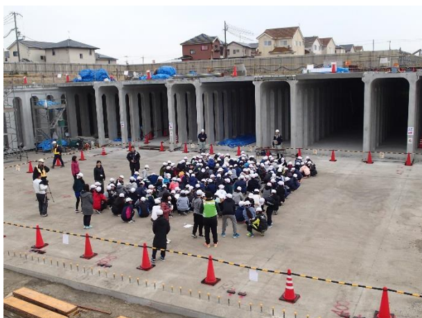
糸引公園雨水貯留施設 施設見学会
