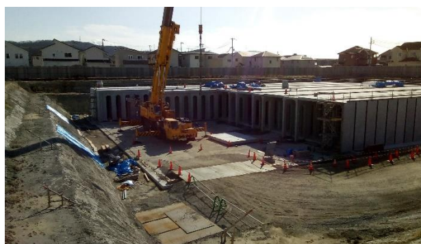
糸引公園雨水貯留施設 施工写真
