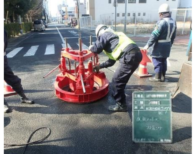
マンホール蓋取替の状況 (円形カッター工法)
