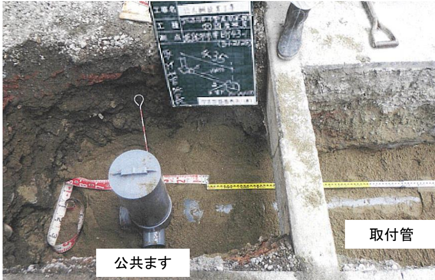
公共ます設置工事
