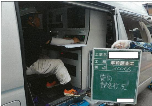
下水道管カメラ調査の状況
