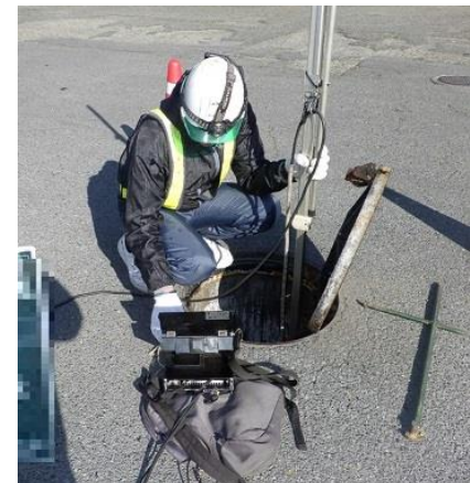
下水道管点検の状況
