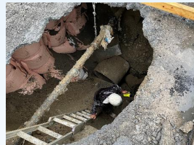
管渠破損による道路陥没 (令和4年6月)
