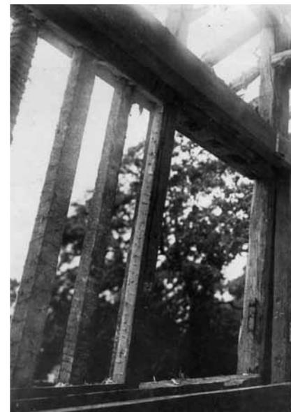
窓の八角形の格子(この窓では、中央の格子の内側の面の鉄板が残存している)
