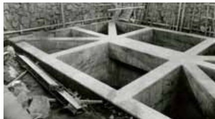
大天守コンクリート基礎
