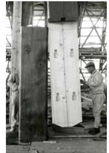
西大柱継手(昭和の大修理)
