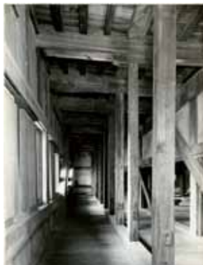
江戸・明治期の修理で補強が施された大天守内部
