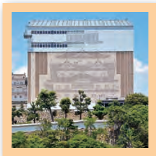
姫路城大天守修理見学施設 「天空の白鷺」
