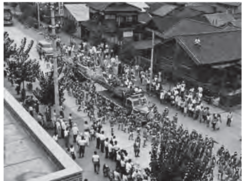
心柱を運んでいる様子
