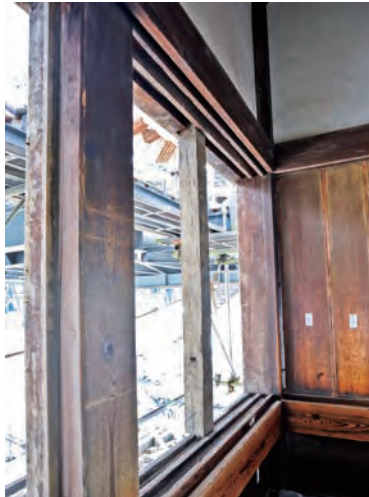
窓枠（(公財)文化財建造物保存技術協会提供）
