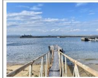
① 清水の浜 浮棧橋
