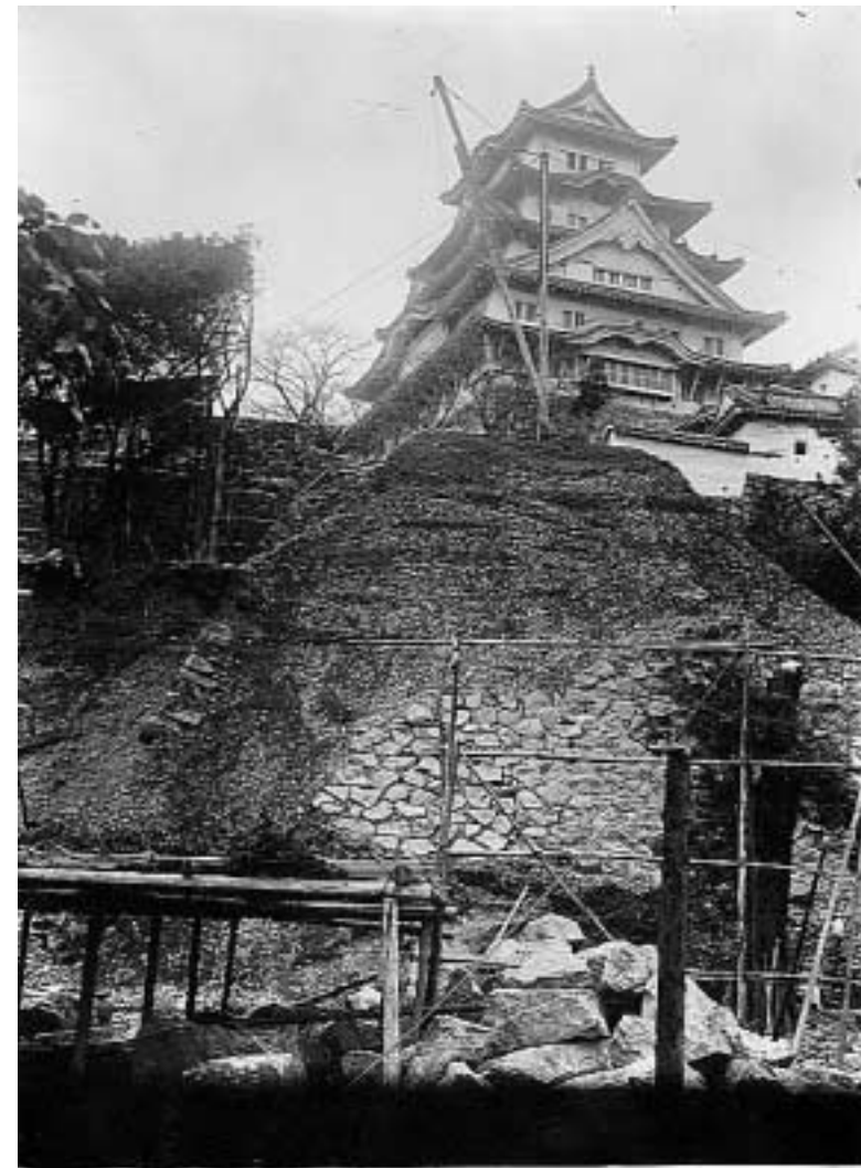
写真2；積石の解体状況
