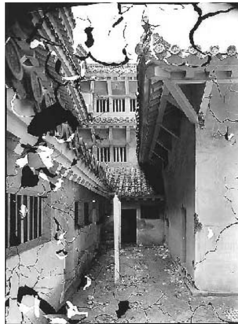
◆写真の一例：「台所櫓南西隅より北を見る」
