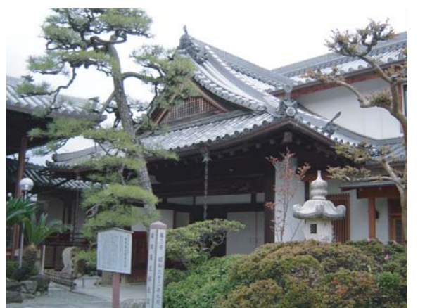
報恩寺に移された玄関
