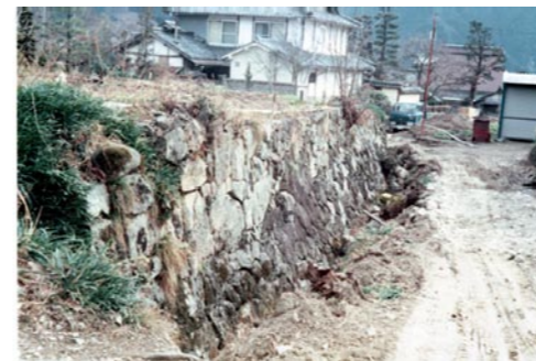
写真 3 武家屋敷地に残っていた石垣 (現存せず)
