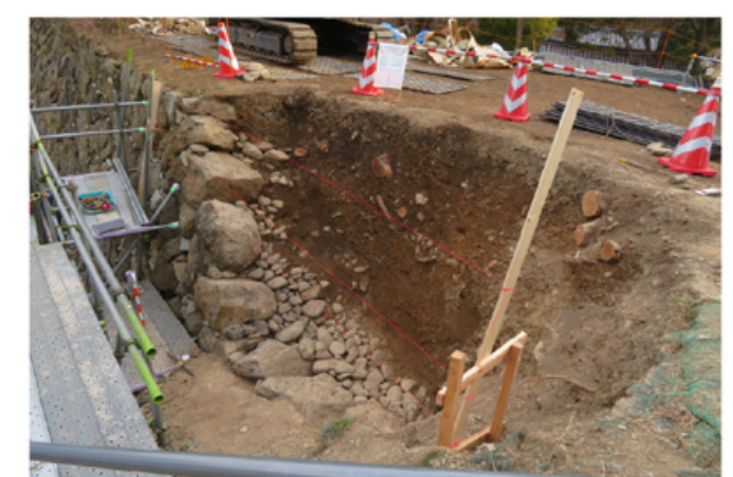
木の根の撤去と石垣の解体（栗石の状況）
