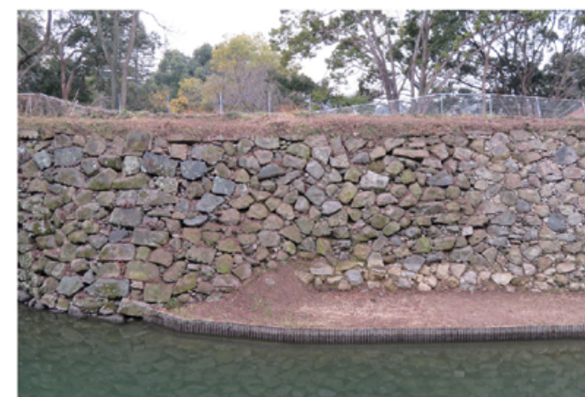
間詰石補充作業前の状況
