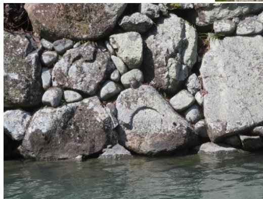
12 大手門東側内堀石垣の転用石
