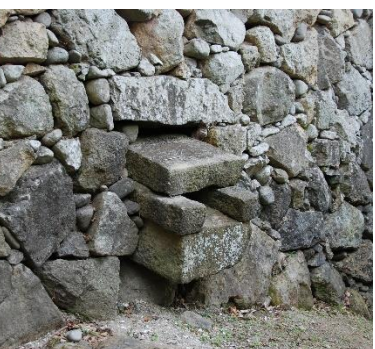
西の丸西面石垣
