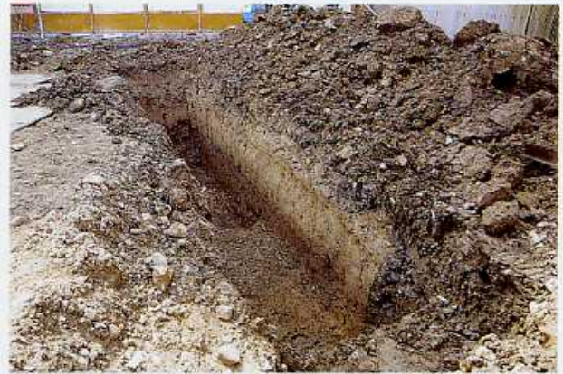
マンション建設予定地トレンチ状況(北東から)
