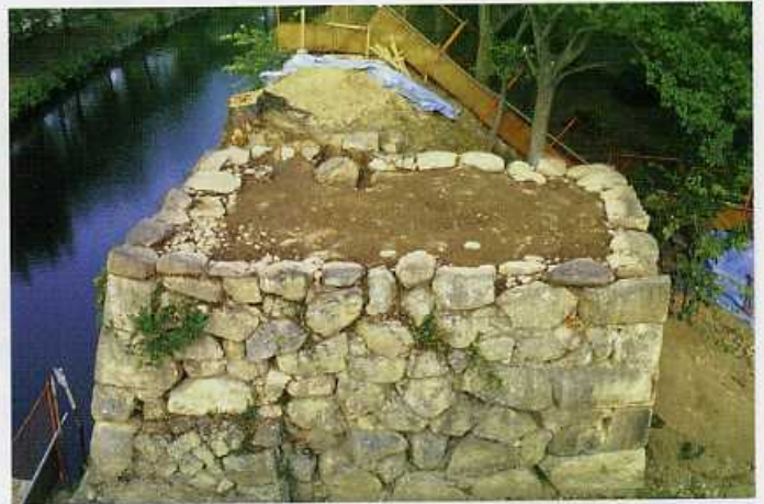
北勢隠門東側石垣の上面（西から）
