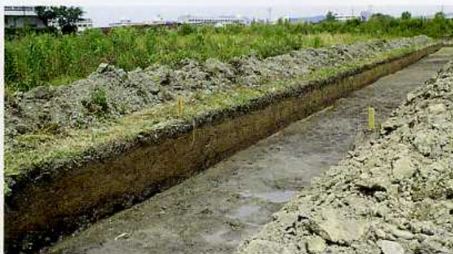
3区の調査の様子（南西から）
