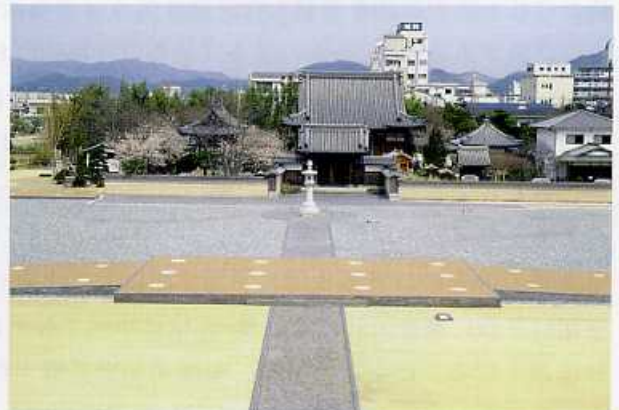
整備された中門・金堂の基壇（南から）
