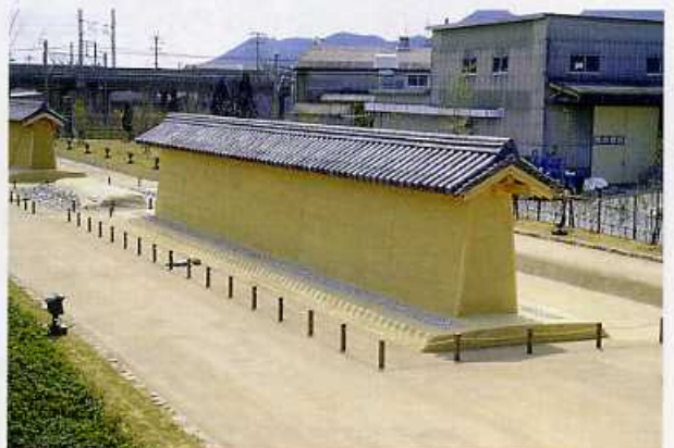
寺域西側の復元された築地塀（北東から）
