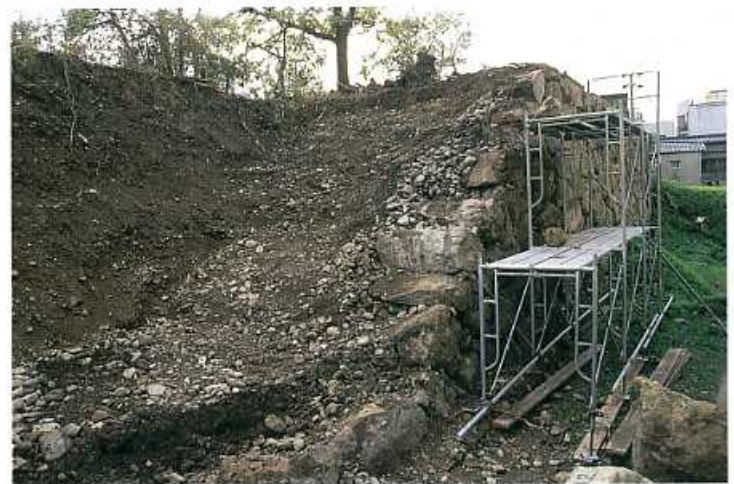
内京口門の石垣解体の様子
