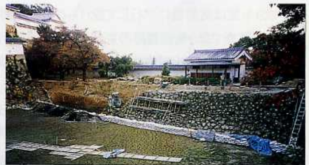
三国堀南石垣東半部解体中(北西から)
