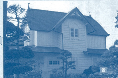
外国人技師住宅(クラブハウス)
