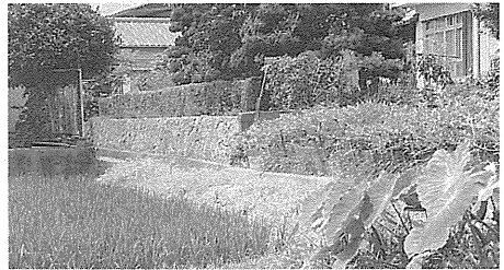
第1砂堆 (県立南高等学校の南)
