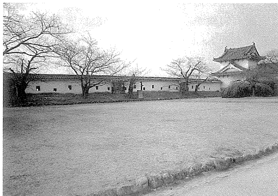
西の丸南端部のワの櫓東方土塀の内郭面
