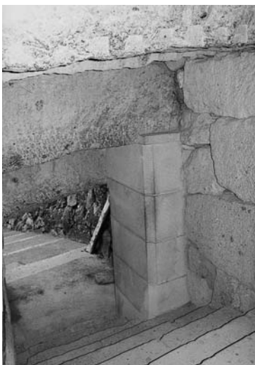
【帯の櫓西端部潜道石段内部の補強】
