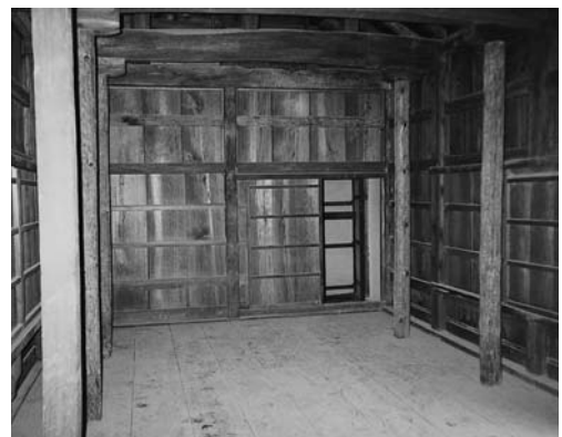
【との一門上層内部の補強柱】
