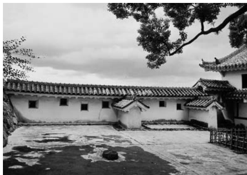
【帯郭櫓北方土塀の控壁】
