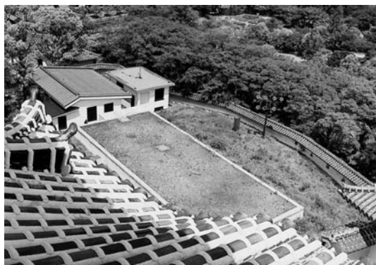
【現在のポンプ室と貯水槽跡】 (半地下の水槽は残し、上屋のみ撤去)
