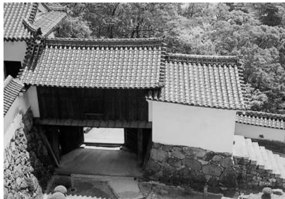
【鯰瓦の揚げられていないとの一門とトの櫓の屋根】
