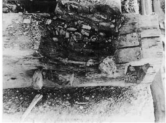
【柱で圧縮を受けた土台】
