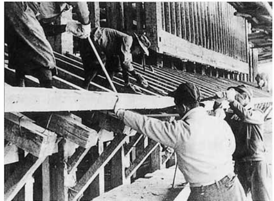
【屋根部材の解体】
