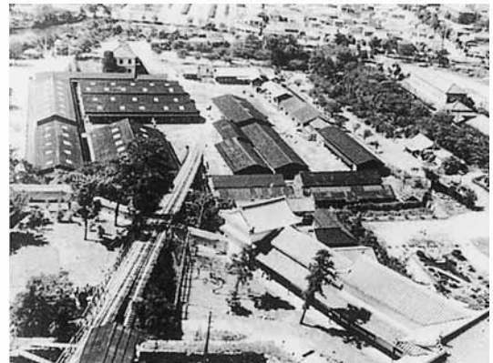
【三の丸一体の作業小屋と登り棧橋を素屋根より望】
