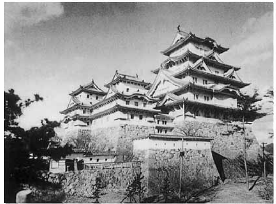
【昭和修理前の天守郭群の建物】
