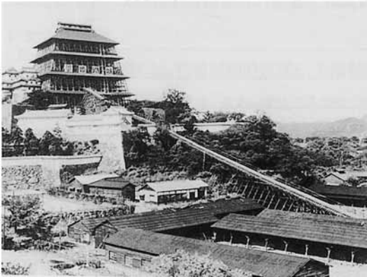
【天守郭の素屋根と登り棧橋】
