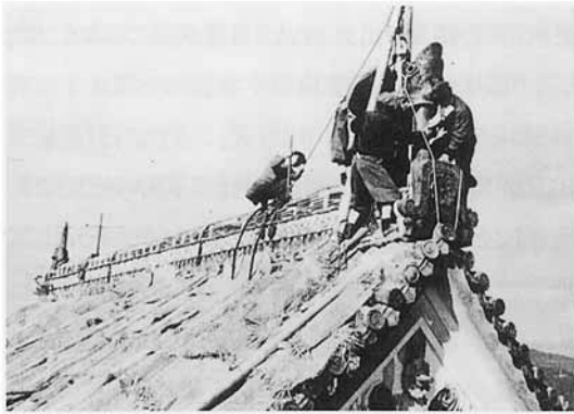
【大天守五重大棟鯨瓦降ろし作業】
