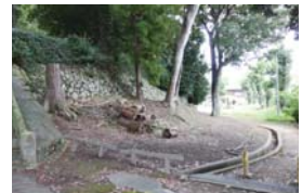
聖岡南東部の石垣と堀跡
